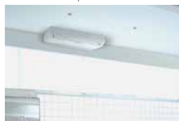
Installation au plafond
